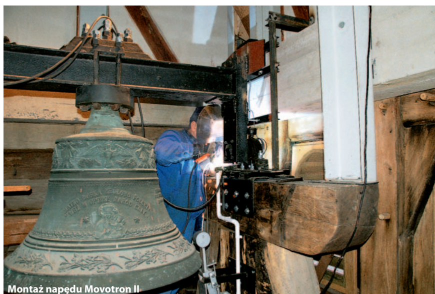
Montaż napędu Movotron II
