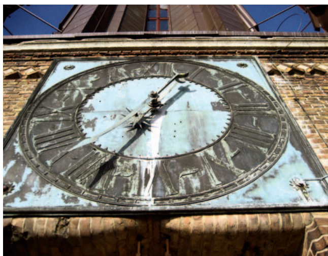
Fot. 2. Zegar przed renowacją
